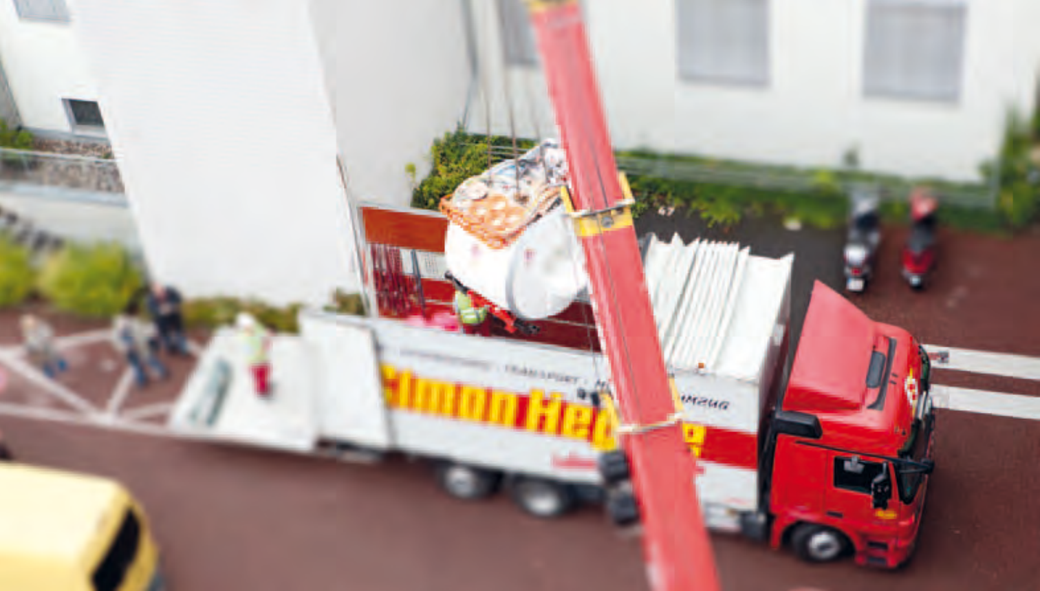
Am Haken: Schwerlastkran mit MRT
